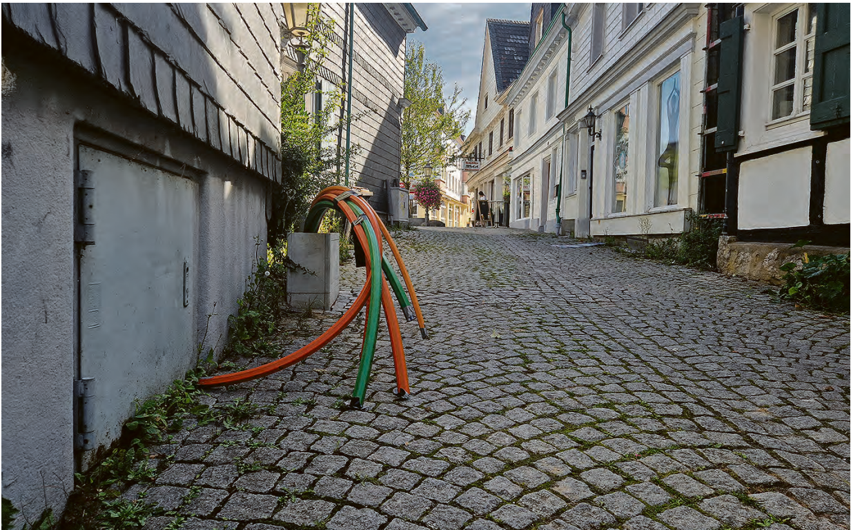
Ein Bild mit Symbolcharakter: Die Arbeiten zum Ausbau des Glasfasernetzes sind noch nicht abgeschlossen.
