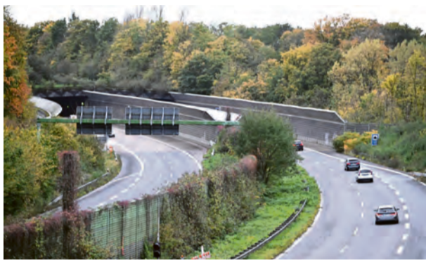
Im Tunnel Birth auf der A44 bei Velbert stehen Bauarbeiten an. Foto: Mathias Kehren
