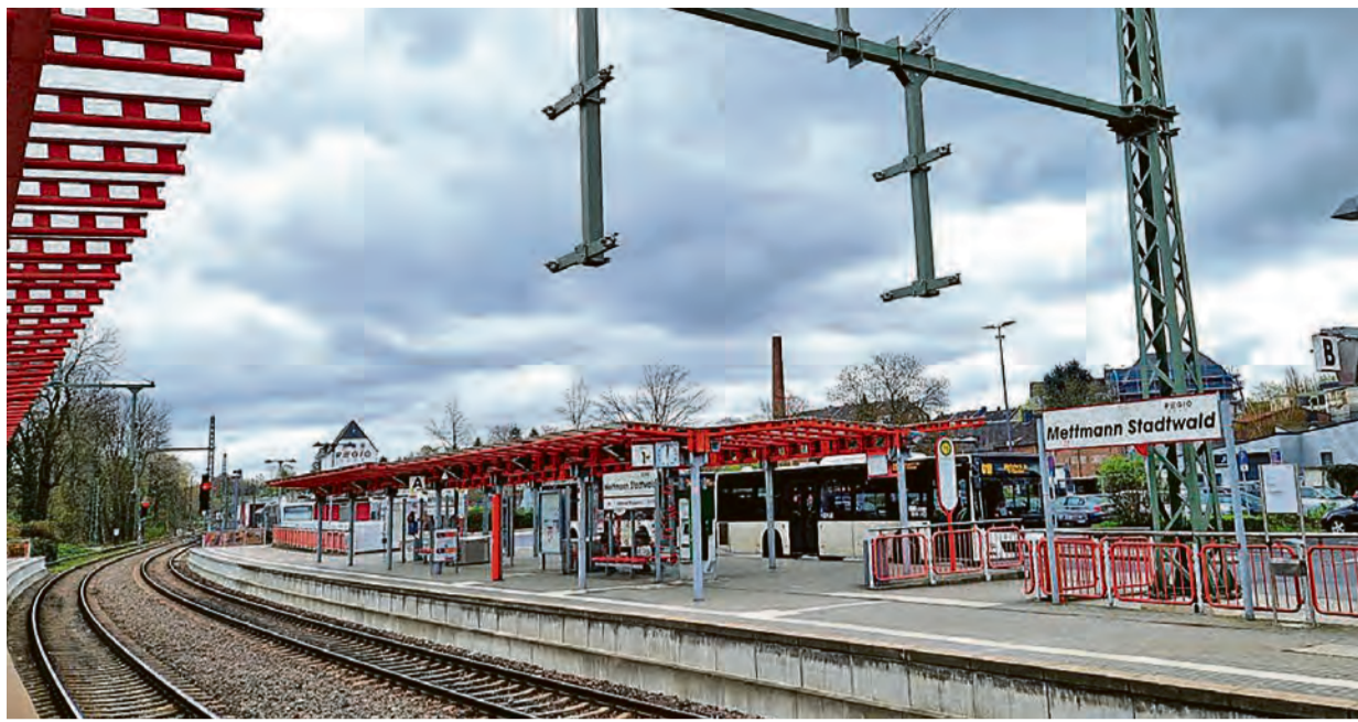
Sichtbares Zeichen der anstehenden Elektrifizierung: der Mast für die Oberleitung im Bahnhof Stadtwald. Foto: Kling
