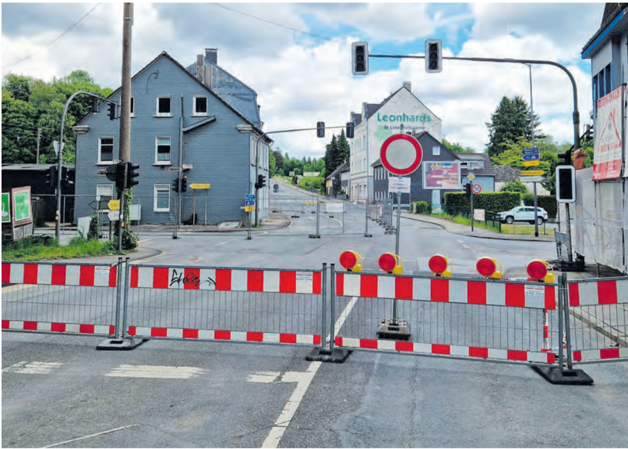
Alles dicht: Wegen eines einsturzgefährdeten Hauses hat die Stadt Wuppertal das Wiedener Kreuz komplett abgesperrt. Nur Fußgänger können noch passieren. Foto: Kling
