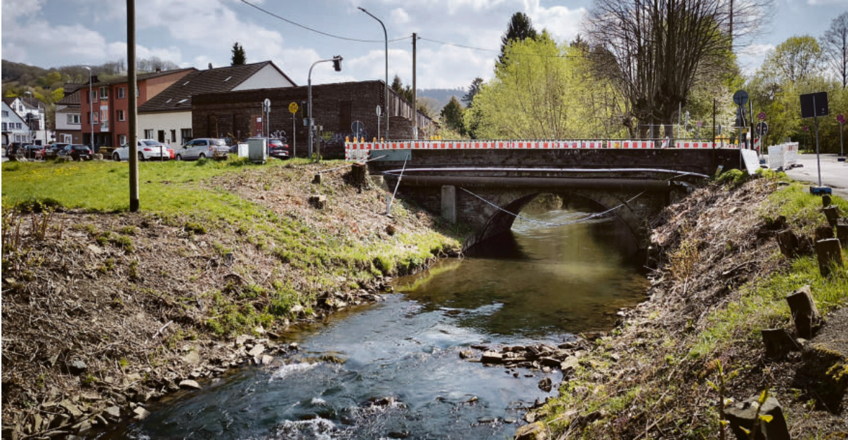
An der gesperrten Brücke über den Deilbach in Nierenhof hängen etliche Versorgungsleitungen. Diese werden über neue Behelfsbrücken geführt, damit die alte Brücke abgerissen werden kann. Foto: Mathias Kehren
