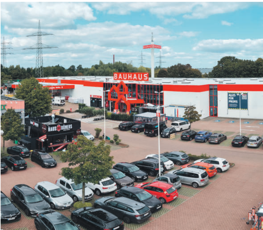
Das neue Fachcentrum an der Grothusstraße 22. Foto: BAUHAUS AG
